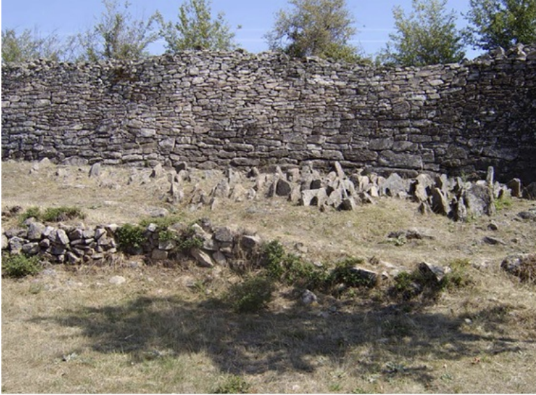
Muralla del lugar de Yecla la Vieja (Yecla de Yeltes, Salamanca), un lugar fortificado con ocupación a partir del siglo V .
